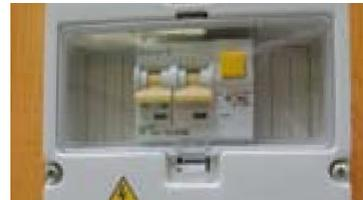
In Serienausstattung: 230-V-Anlage mit CEE-Eingangssteckdose und 13-A-Sicherungsautomat
